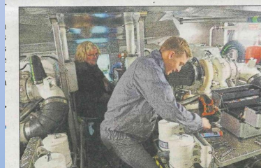
Dans la salle des machines, l'attention est la même.
