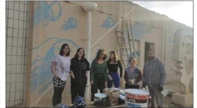
La fresque résulte d'un travail d'équipe. Les BTS Conseil et commercialisation de solutions techniques (CCST) ont trouvé un prestataire pour la réalisation du projet, tandis que les internes ont participé à la mise en forme du projet. (Photo C. Go.)
